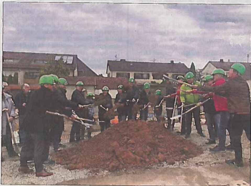
Beim ersten Spatenstich am BB-Wohnbau-Projekt Haulucke 61 in Maichingen flog mächtig Erde durch die Luft Foto: red
